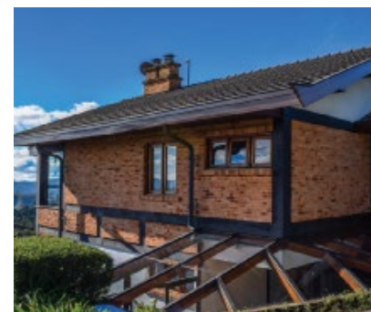
Casa Térrea/Nova Capivari
